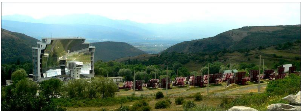
Figure 1.1 : Le four solaire d'Odeillo. A gauche, le miroir parabolique qui concentre les rayons du soleil. A droite, les 63 héliostats qui réfléchissent les rayons vers le miroir parabolique (Source : Wikipédia. Four solaire d'Odeillo. [32])
